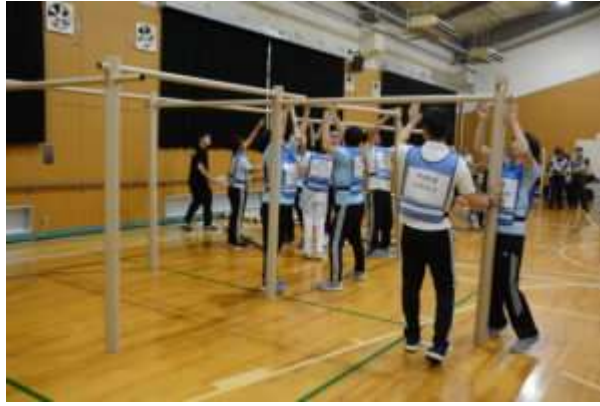
避難者受け入れスペースを確保し、紙管にて間仕切りを設置
